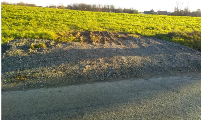
Figure 100 : Exemple d'une entrée de champ empiercée (BV du Ter : décembre 2018)
