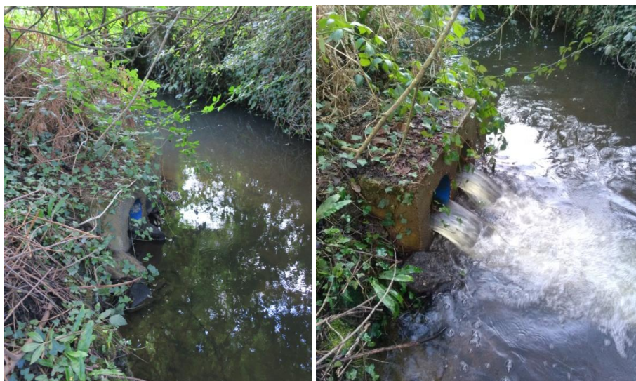
Figure 27 : Photos du point de prélèvement SDY4 à l'aval du rejet du lit bactérien (1500 EH) de la BAN. A gauche, en novembre 2017 (pas de débit rejeté) et à droite en janvier 2018 (rejet dans le cours d'eau)
