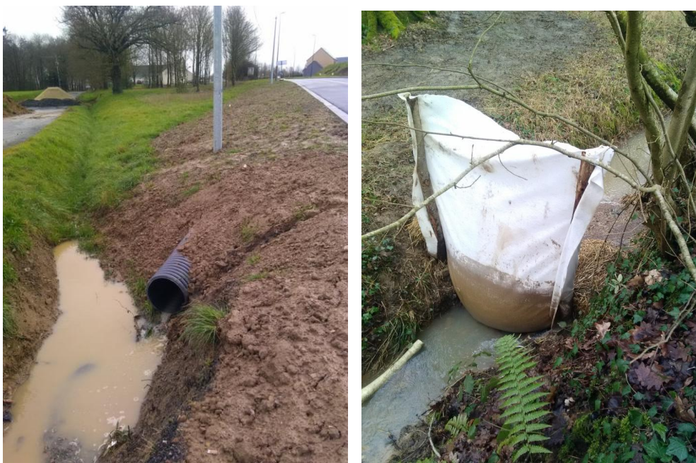
Figure 106 : A gauche, ruissellement et transfert d'eau chargée en MES sur une zone urbaine en travaux et à droite, mise en place d'un barrage (paille) pour limiter le transfert de sols au cours d'eau
