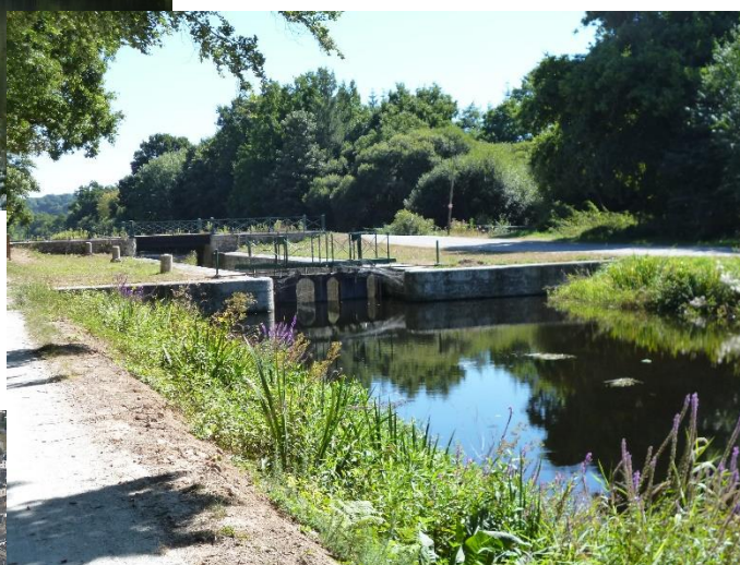
Figure 19 : Blavet canalisé Crédit : SMBSEIL, 2013
