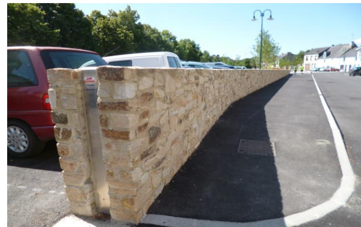
Muret anti-crue à Pontivy
