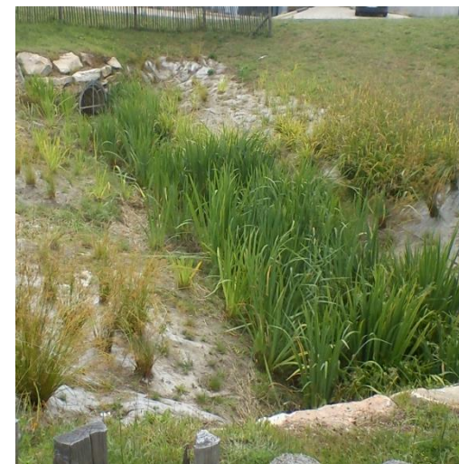
Bassin de phytoépuration
